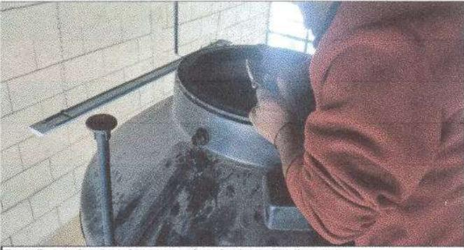
Foto 5: sustrucion de accesorios de deposito de agua
