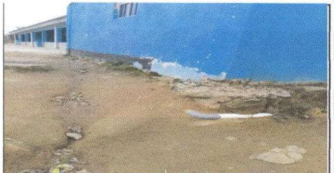
Foto 12: Introducción de 33 metros de drenaje a fosa de baños por pila instalada.
