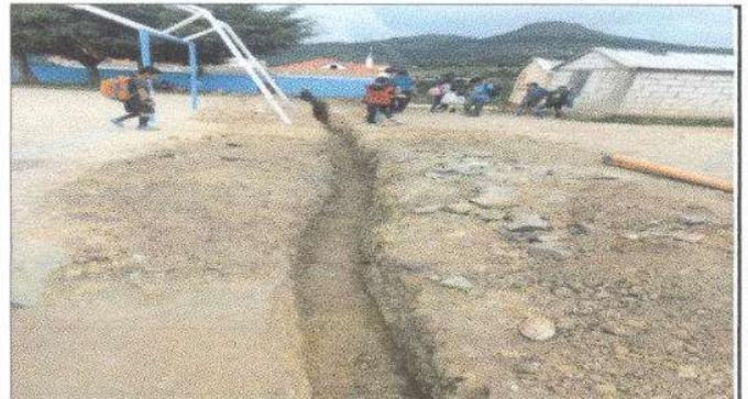
Foto 4: sustrucion de tuberia PVC linea principal de aguas negras
